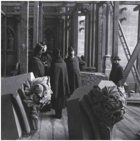
Construction du portail néogothique de Paul Tornow : Scène de chantier © Archives départementales de Moselle, Metz
