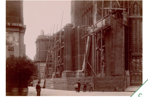
Le démantèlement du portique de J.-F. Blondel. © Collection UDAP de Moselle, Metz
