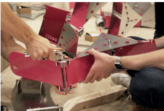
Détail du montage du pavillon X-Mesh et l'équipe sous le pavillon monté
