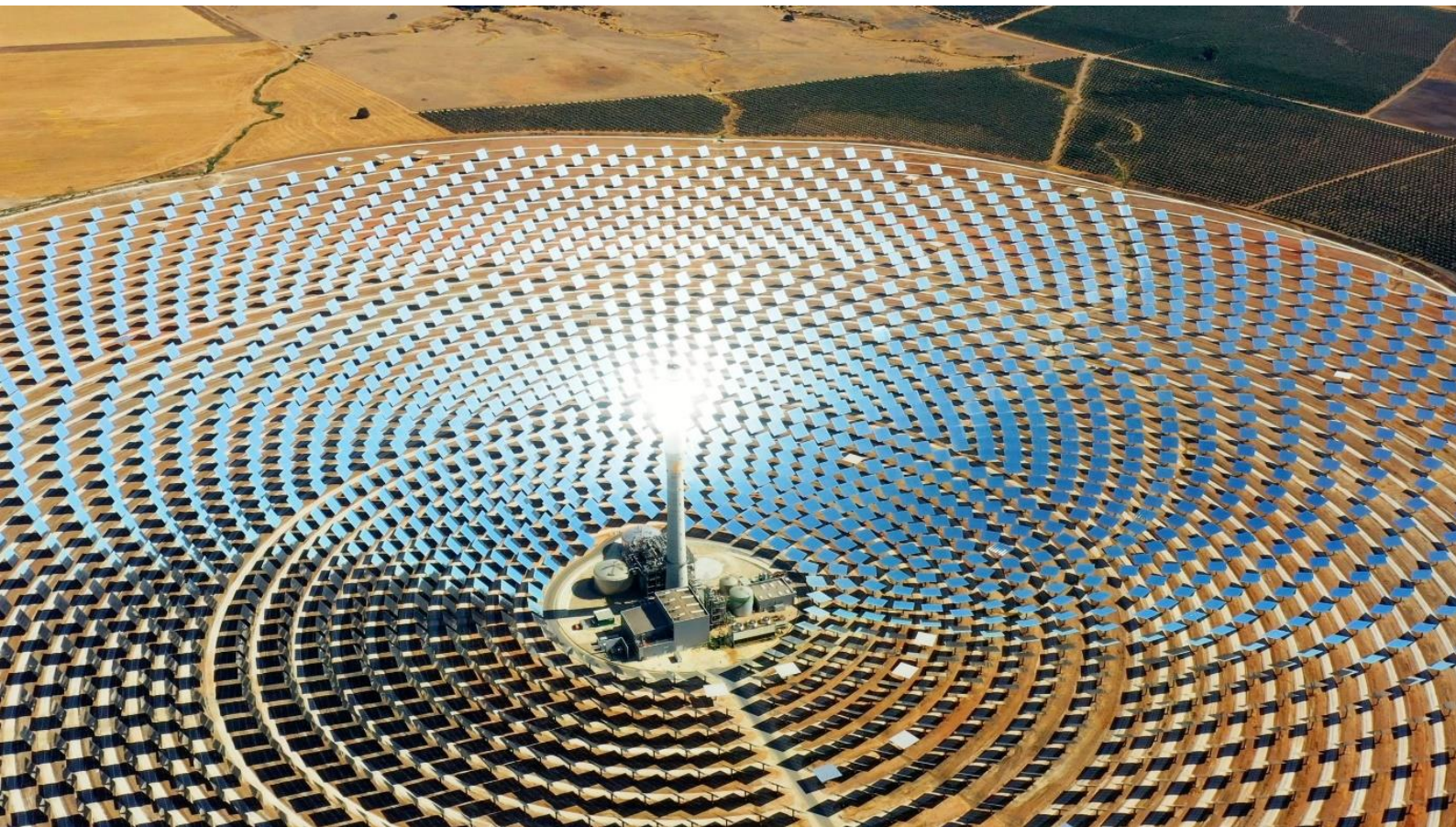
La centrale thermosolaire de Gemasolar près de Séville, le 4 octobre 2011. AFP Photos / Gemasolar Handout
