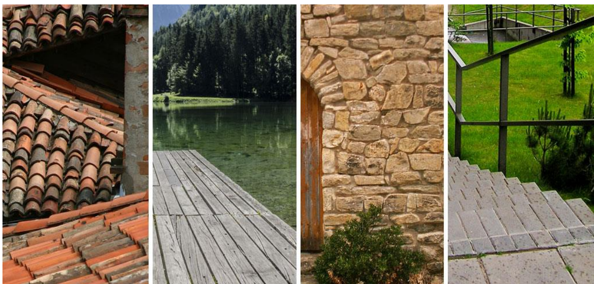
Ici, l'entreprise Invisible SOLAR a réfléchi à l'impact visuel proche mais également lointain à l'échelle du paysage en intégrant totalement (volumes, matériaux, couleurs) les installations photovoltaïques dans leur contexte.
