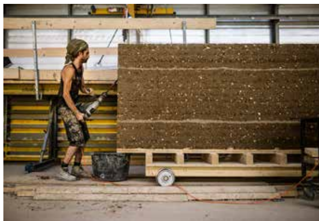
La maison des plantes de Ricola, Herzog & De Meuron, Laufen - Suisse, 2014 Structure en béton armé et façade auto-porteuse en pisé
