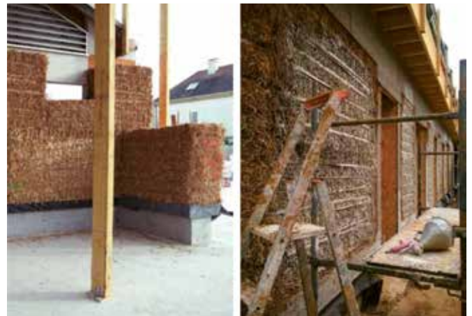
École maternelle Les Boutours, Rosny-sous-Bois, Architectes de la ville de Rosny-sous-Bois, 2017 Ossature et charpente en bois, remplissage en paille
