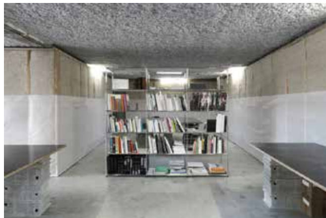
Réhabilitation d'un ancien garage en bureaux, BAST, Toulouse, 2019 Structure poteaux-dalles existante, isolation en laine de chanvre
