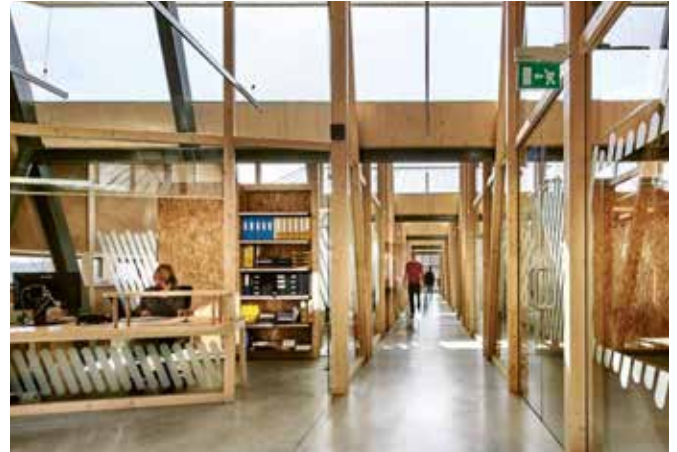
Siège social du CIAS-SIVOM, Apaches architectes, Montredon-des-Corbières, 2015 Structure bois (douglas) et isolation en bottes de pailles fournies par les agriculteurs de la région
