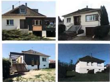
Maison des années 60 transformée avec une extension contemporaine, Patrick Flintz.
