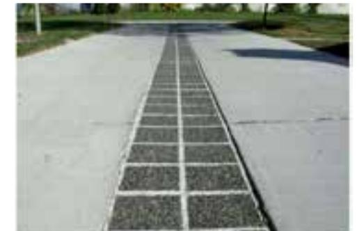
Chaussée avec caniveau central en pavé poreux
