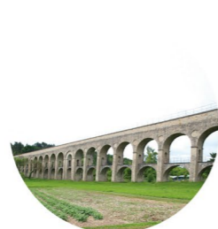
2. Aqueduc de la Vanne
