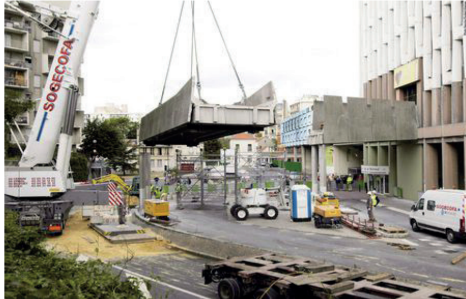
Démolition de la passerelle 2005
