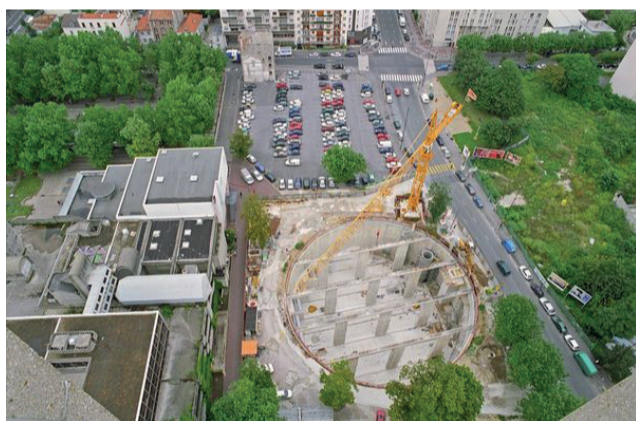
Début des travaux du bassin de rétention d'eau.
