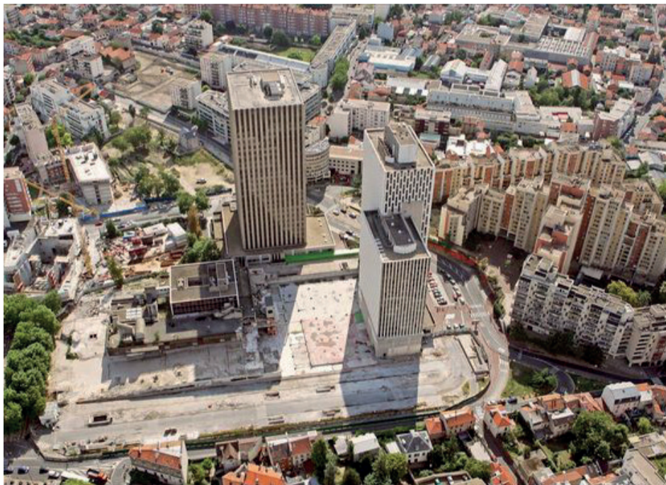
Démolition du coeur de ville
