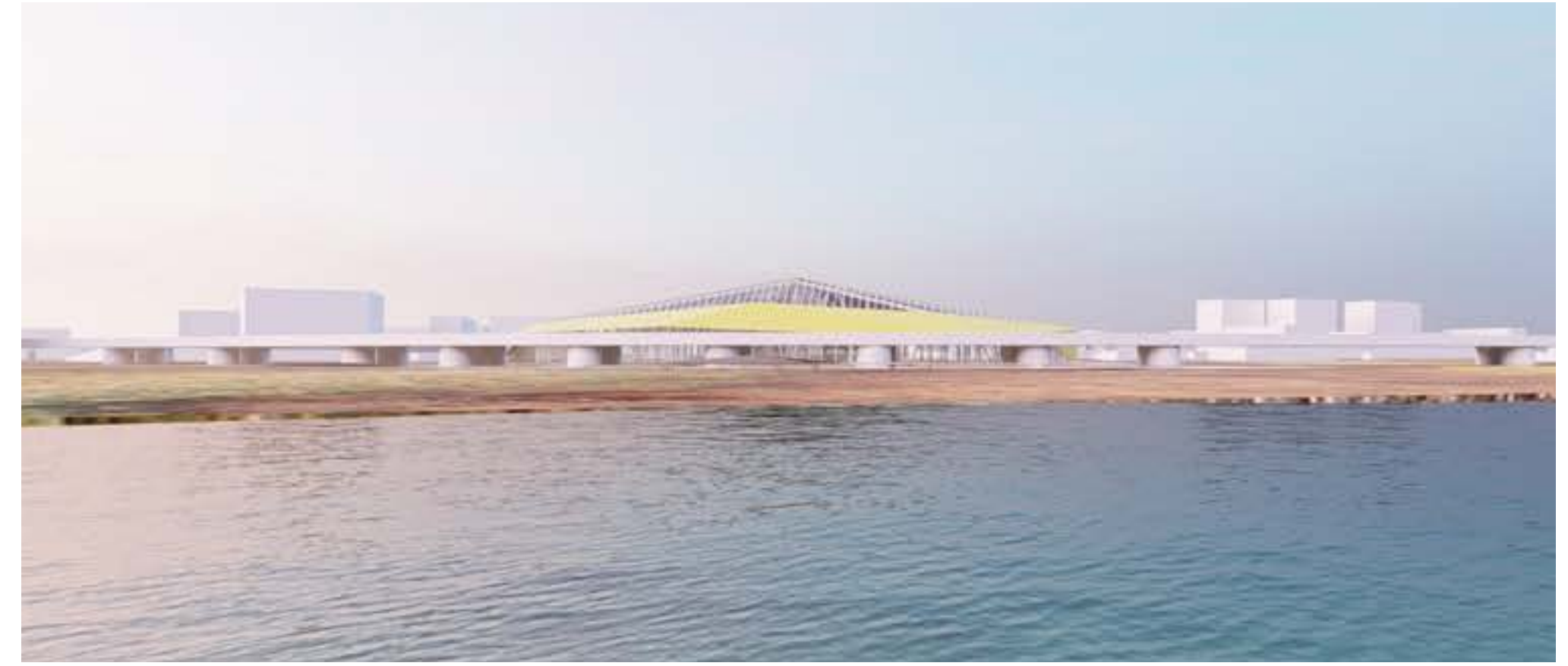
Le projet s'approprié et fait corps avec l'infrastructure
