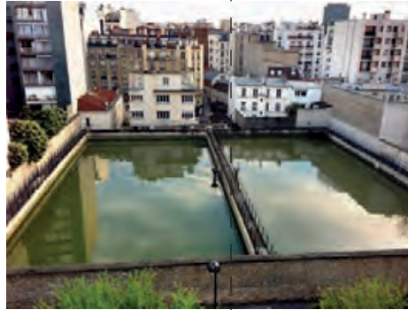
Réservoir de Grenelle
