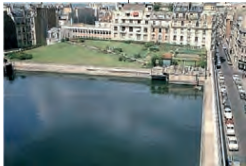
Réservoir de Passy
