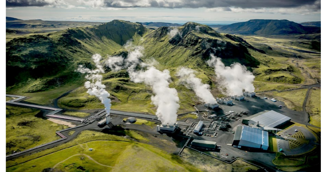
Centrale géothermique de Hellisheidi, 24 octobre 2018, © Arni Saeberg CC BY-SA 4.5
