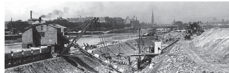
Construction du port de Francfort Osthafen dans les années 1920.
