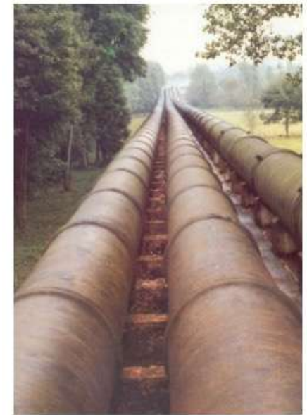
Conduits de l'aqueduc de la vanne
