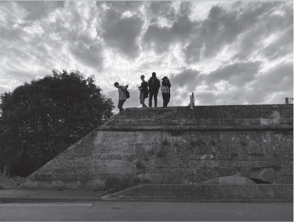
Etudiants de l'Ensa Paris-Malaquais sur le Canal de Craponne à l'entrée d'Arles : l'ouvrage a été découpé pour faire place à un rond point qui s'enroule autour des restes de l'aqueduc. L'eau de cet ouvrage, commencé au XVe siècle, est relevée par des pompes. ©Marc Armengaud 2022.
