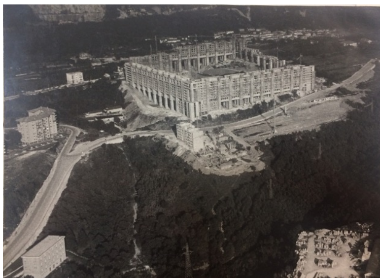
2. Rozzol-Melara, en cours de construction, circa 1975
